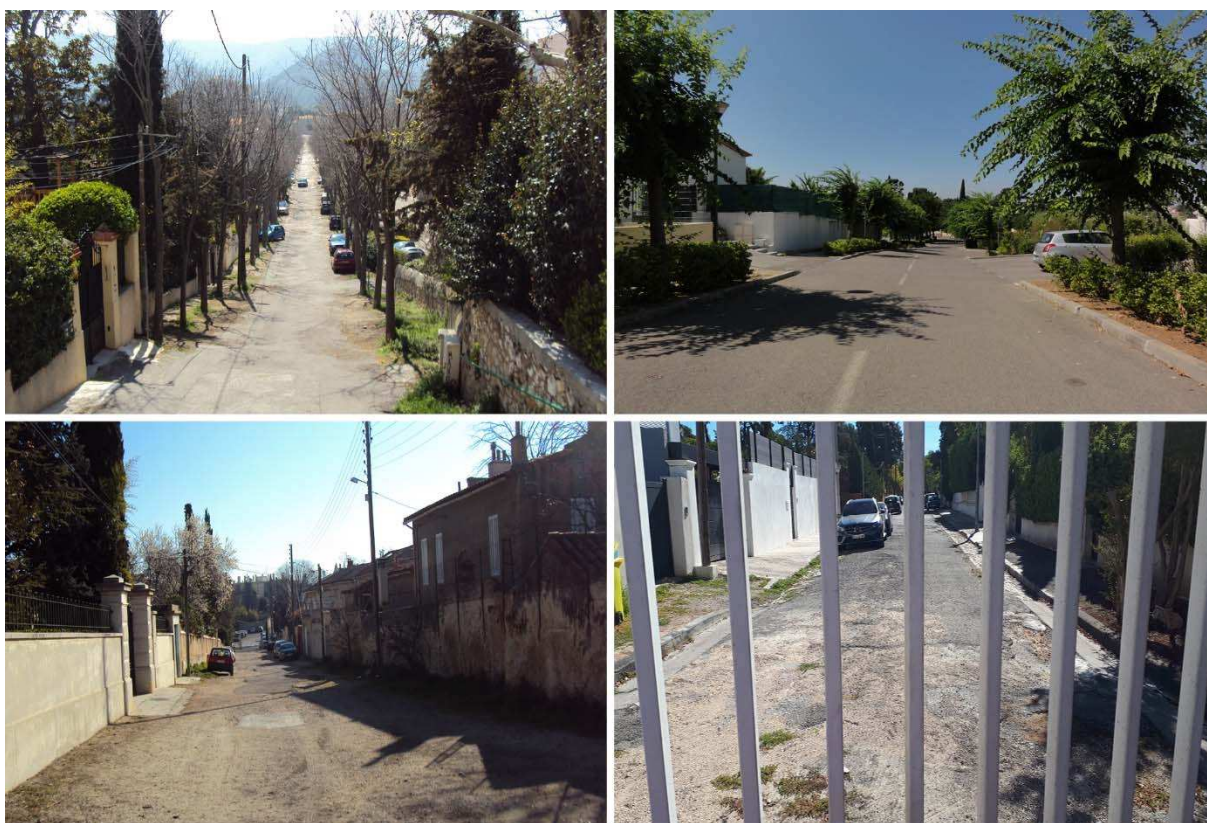
Photo 27-1 Le boulevard Poméon (état dégradé), 9 ème arr.
