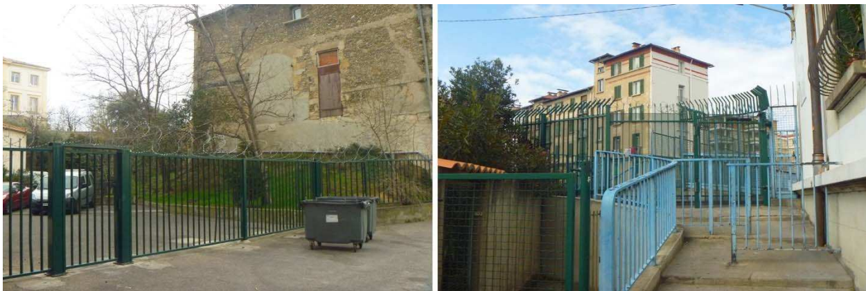
Photo 10-1 Pics montés sur la grille, résidence les hautes rives, 13 ème arr.
