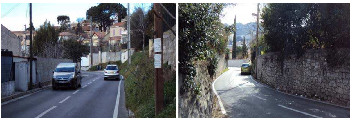
Photos 17-1 et 2 le boulevard des Libérateurs
