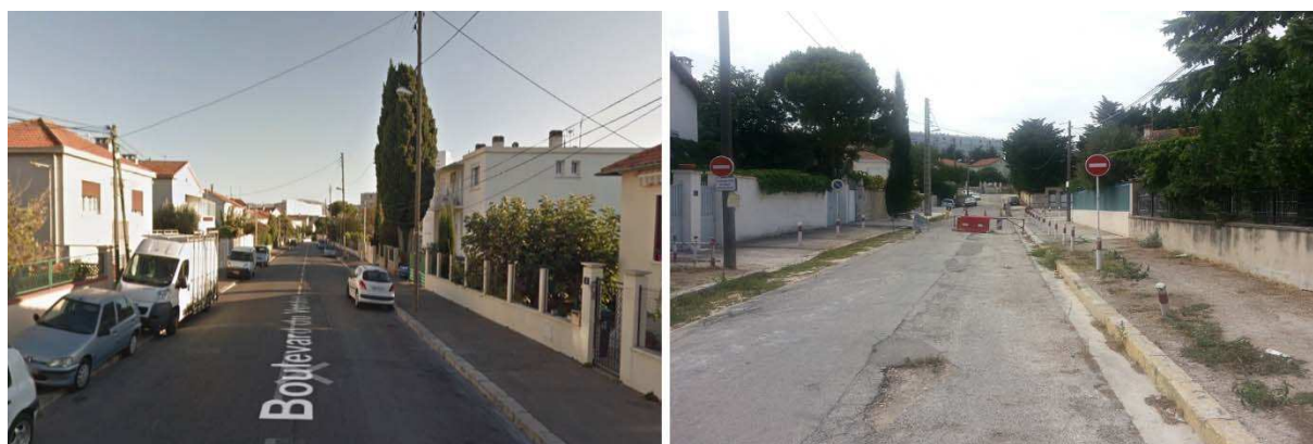
Photo 26-1 Voie entretenue (publique) boulevard du Verdon, 14 ème arr.
