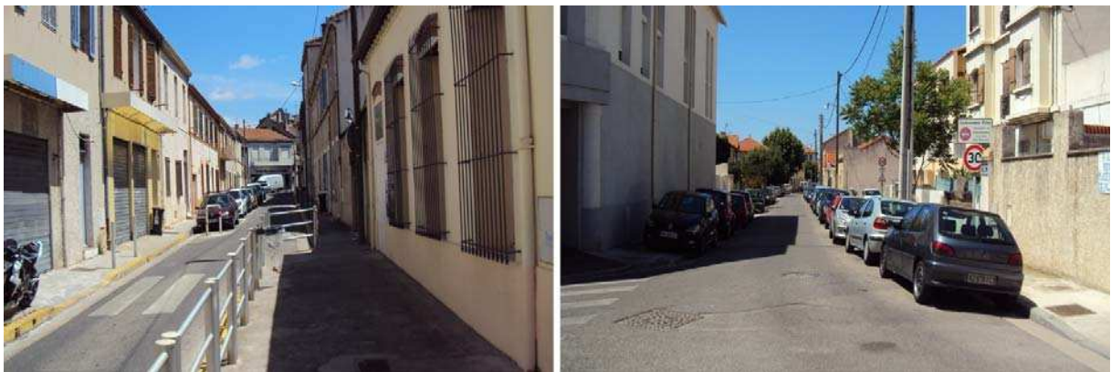
Photo 41-1 et 2 Le boulevard Pagès
