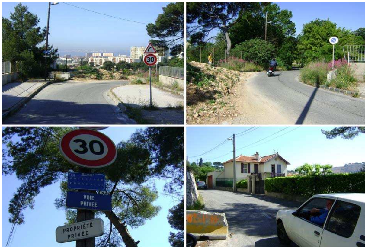
Photo 50-1 à 50-4 Boulevard Provençal
