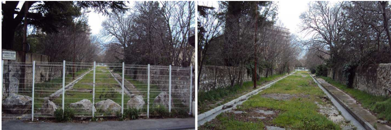
Photo 11-1 et 11-2 Avenue Solvert, 9 ème arr.
