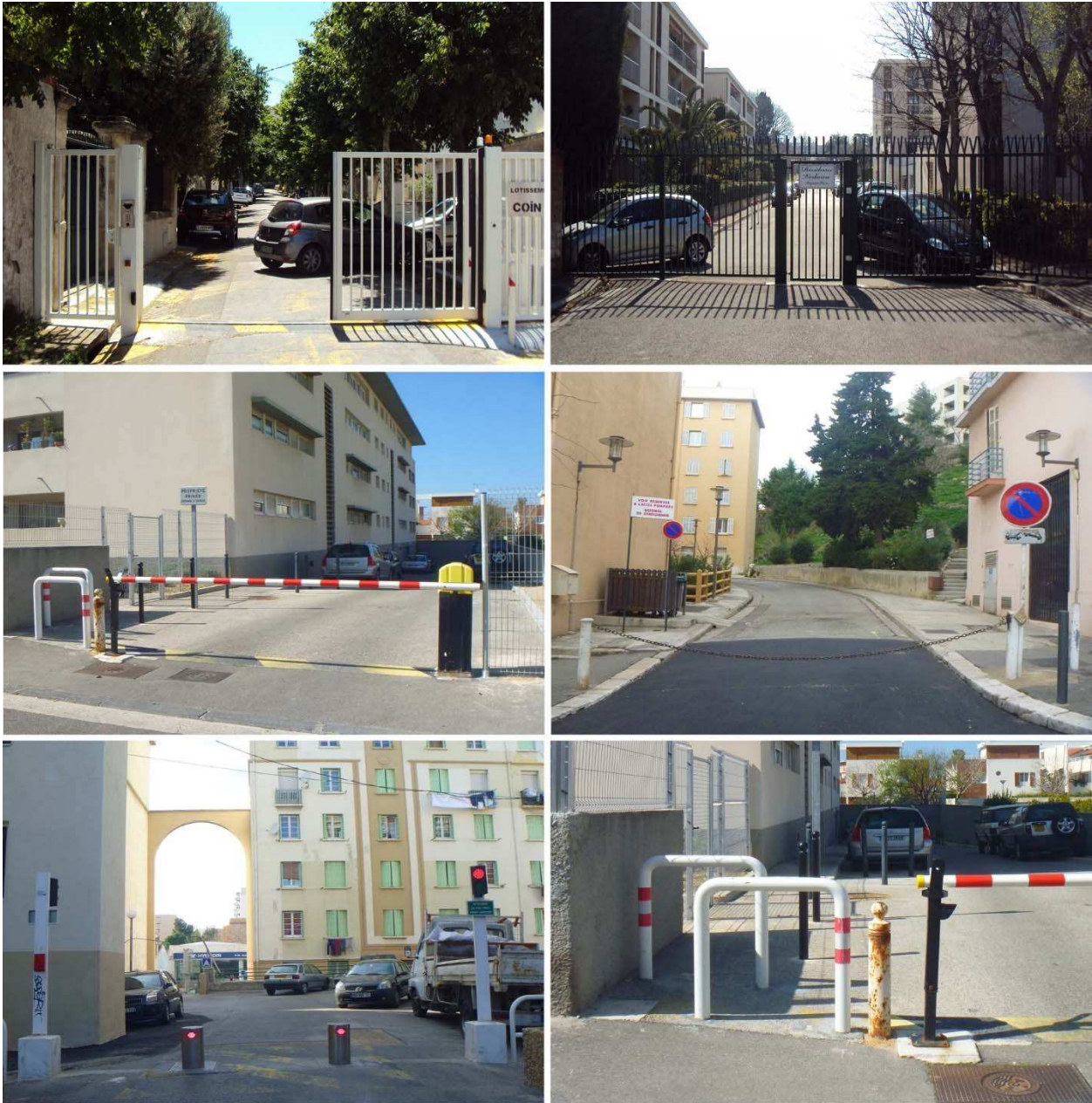
Photo 6-1, Portail et portillon étanches, lotissement Coin Joli 9 ème arr.
