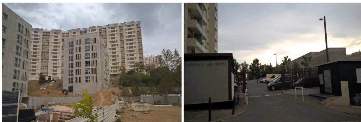
Photo 13-1 Nouveaux ensembles sociaux construits, Malpassé, 13 ème arr.
