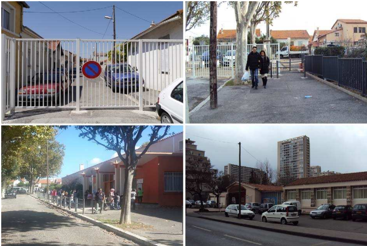
Photo 51-1 Barrière inamovible dans le lotissement Coin Joli (rue Cazalet Jacquet), 9 ème arr.
