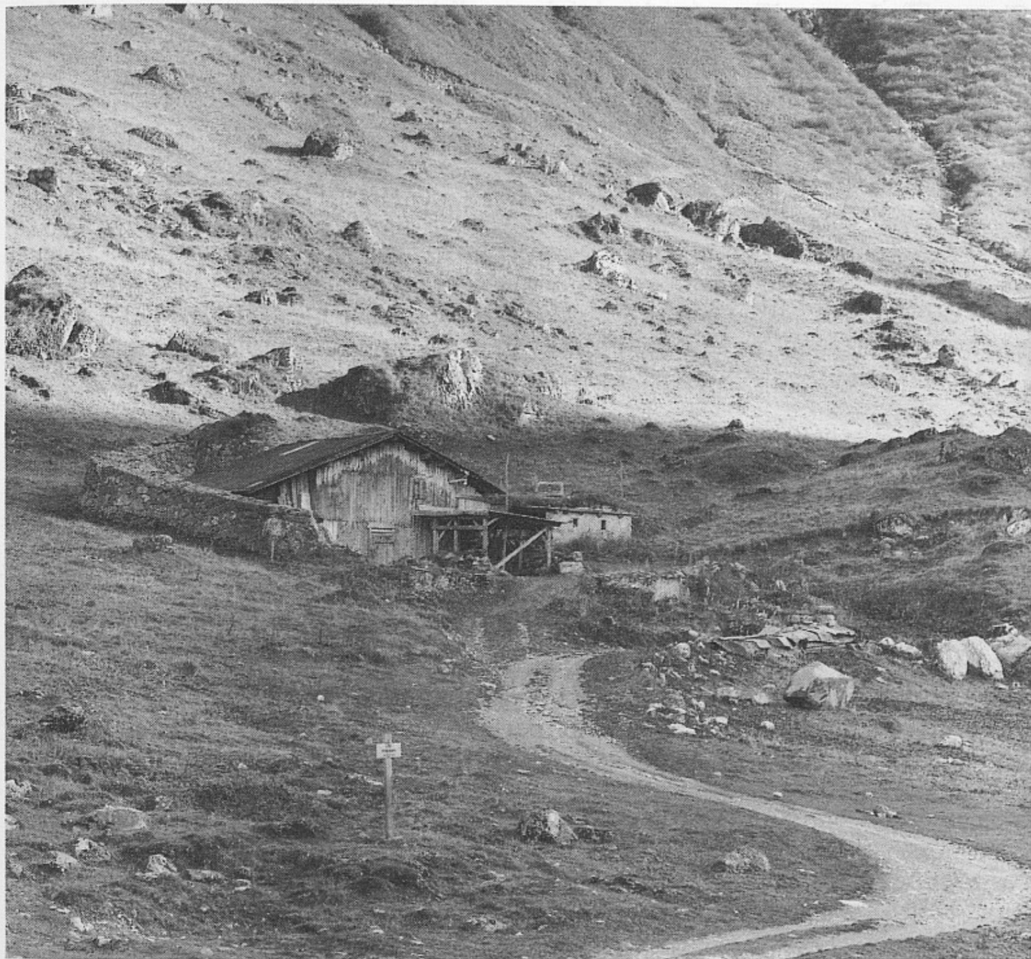
21. Village de Treicol, chalet protégé par un mur de pierre contre l'avalanche. Cliché du Service régional de l'Inventaire.
